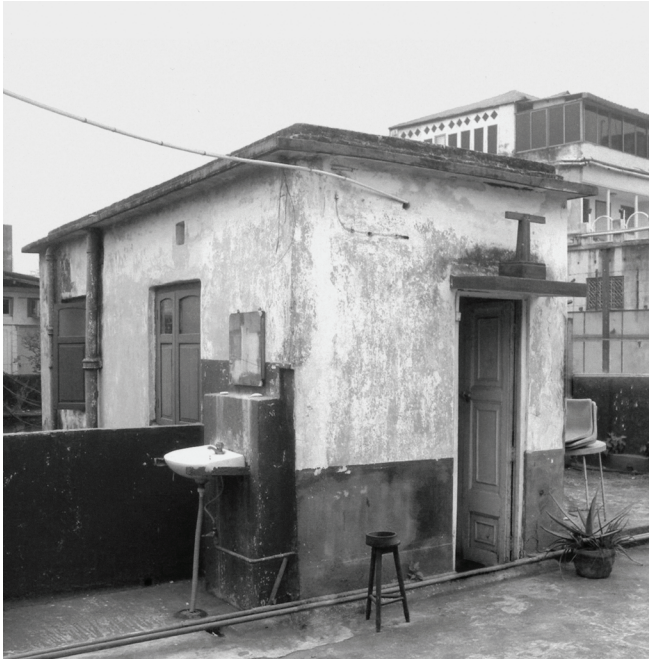
Det lilla huset på takterrassen.
